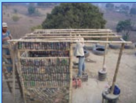
Baño con Eco-ladrillos
