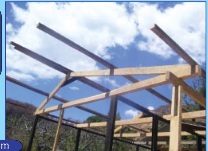
Techo expandido para corredor adicional
